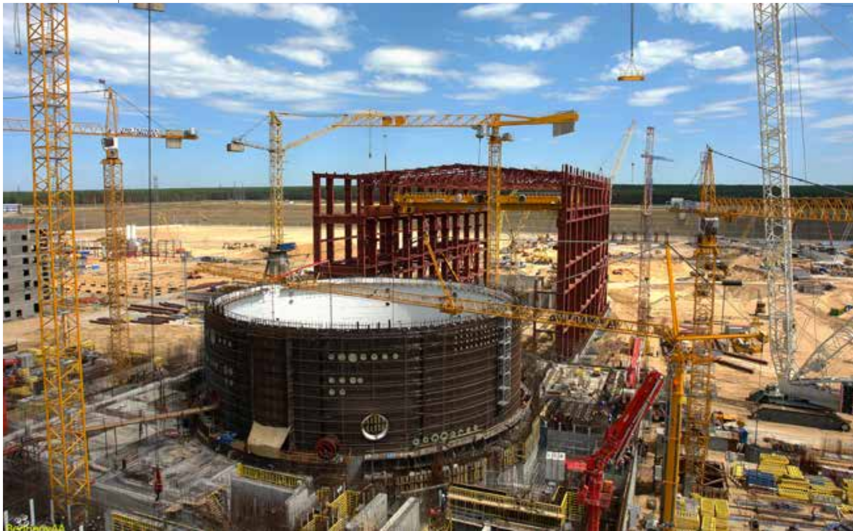
Фото Строительство Новovorонeжской АЭС-2
