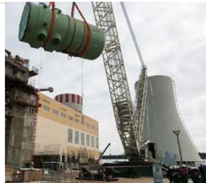
Фото Установка корпуса реактора на энергоблоке № 7 Нововоронежской АЭС
