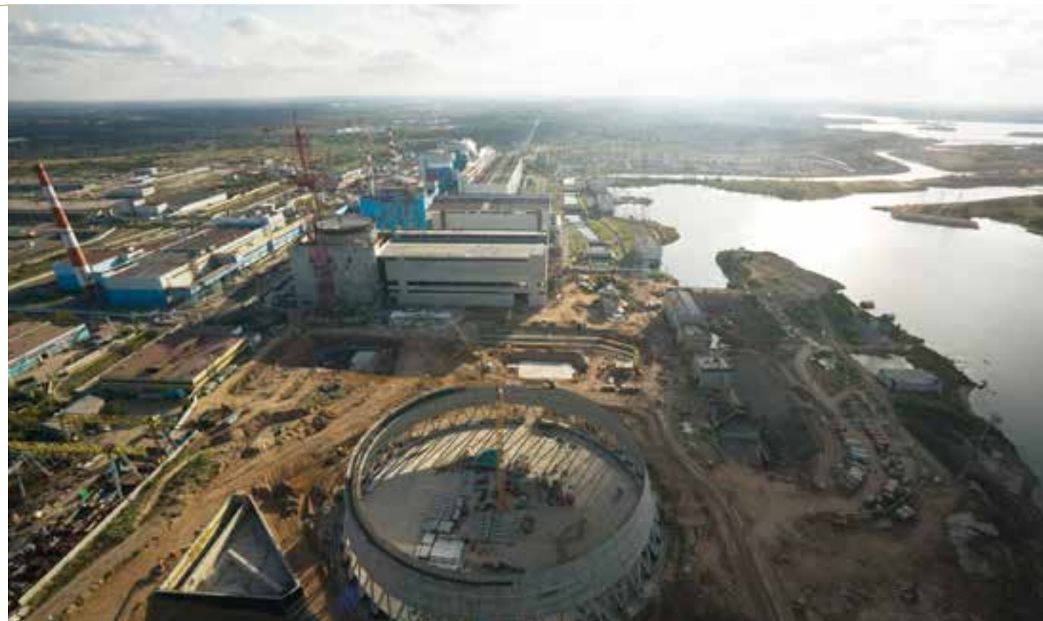
Фото Строительство блока № 4 Калининской АЭС
