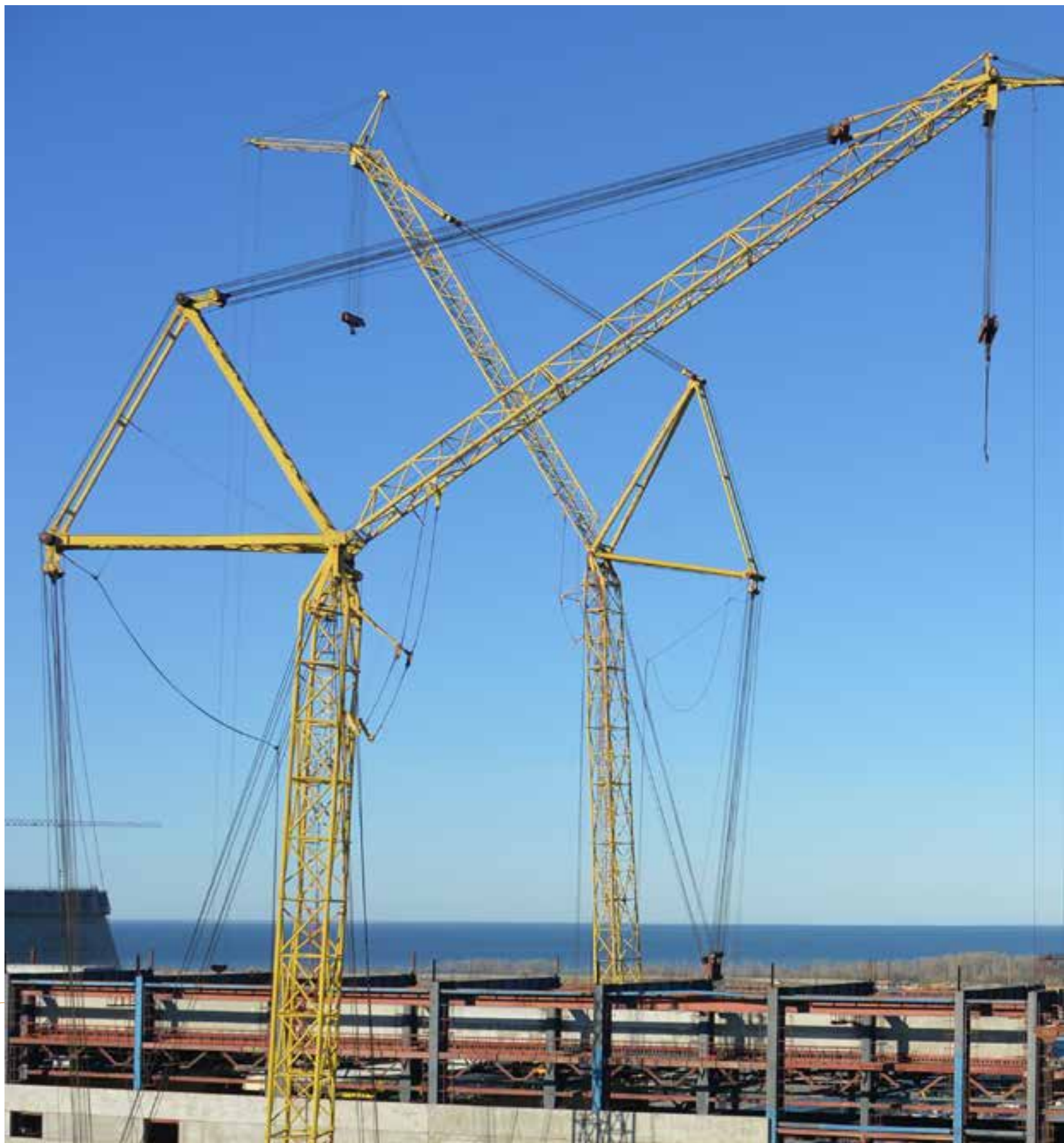
Фото Строительство энергоблоков № 3 и 4 блоков Ростовской АЭС
