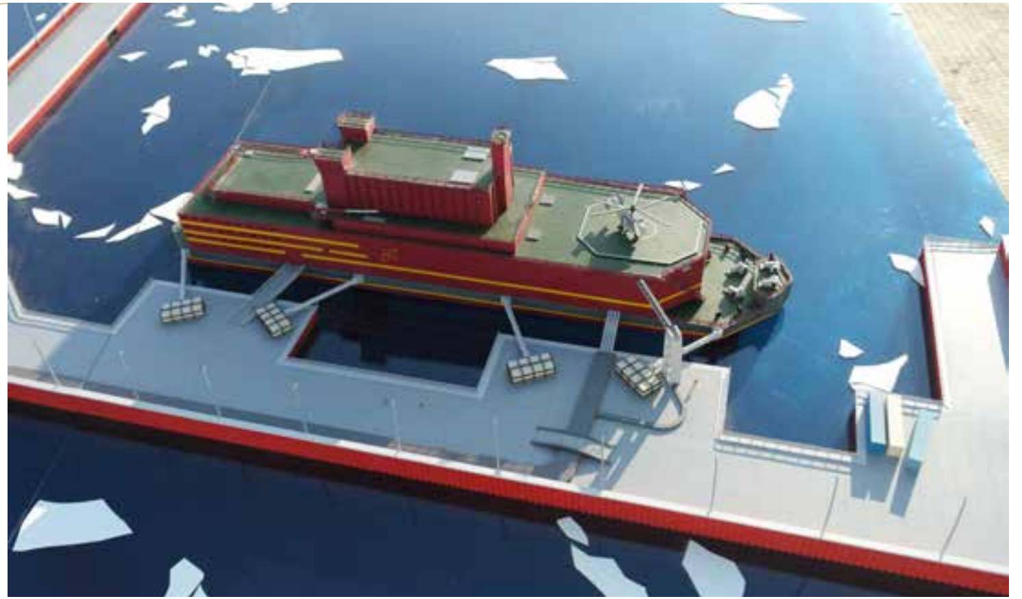
Фото Макет ПЭБ и береговых гидротехнических сооружений
