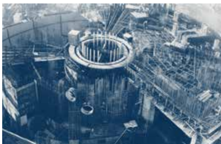
Фото Монтаж биологической защиты реактора ВВЭР-1000 на Нововоронежской АЭС. 1970-е годы
