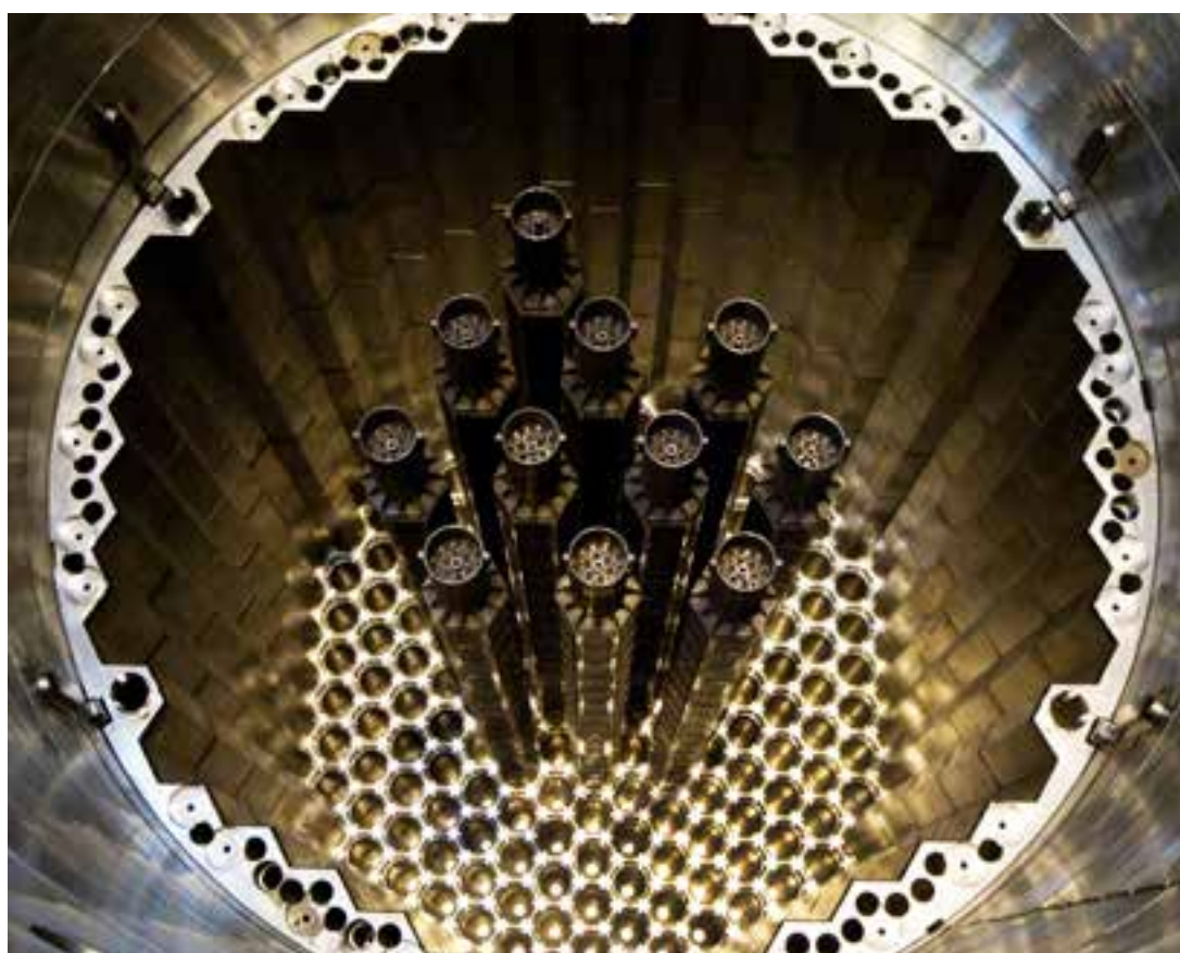
Фото Перегрузка свежего топлива из хранилища в активную зону – один из ответственных этапов физического пуска
