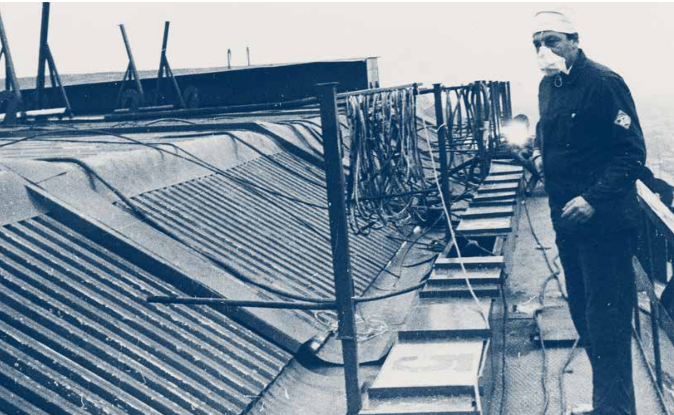
Фото Владимир Асмолов на кровле объекта «Укрытие» Чернобыльской АЭС
