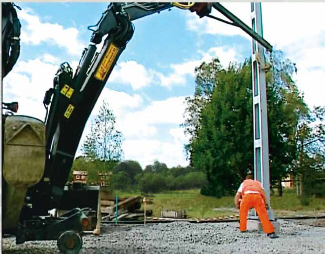
Установка опоры контактной сети
