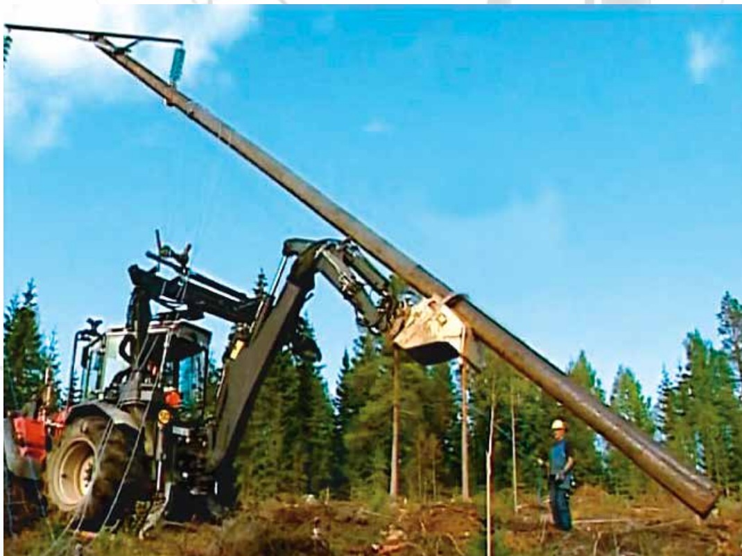
Установка опоры высоковольтной линии
