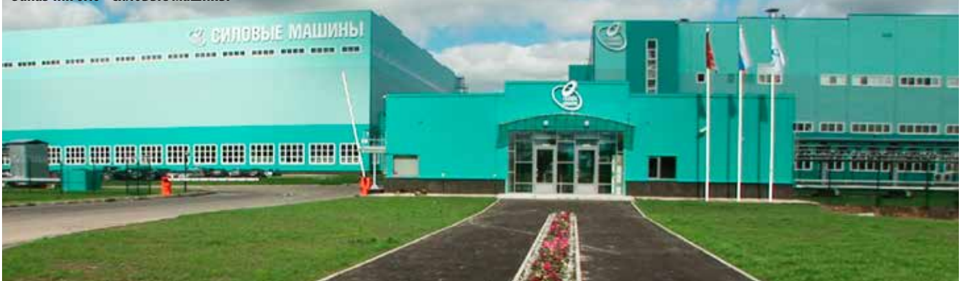
Завод по производству энергетического оборудования в г. Санкт-Петербург Заказчик ОАО «Силловые машины»
