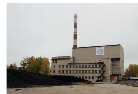
ЭИ-2 (СХК) стал первым в мире промышленным уранграфитовым реактором, выведенным из эксплуатации по варианту «захоронение на месте». Расчетный период безопасности для окружающей среды — 10000 лет.
