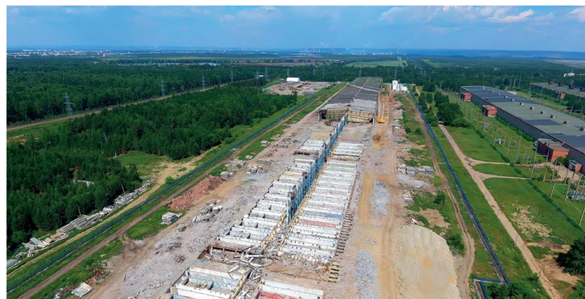
Вывод из эксплуатации здания 804 (АЭХК)
